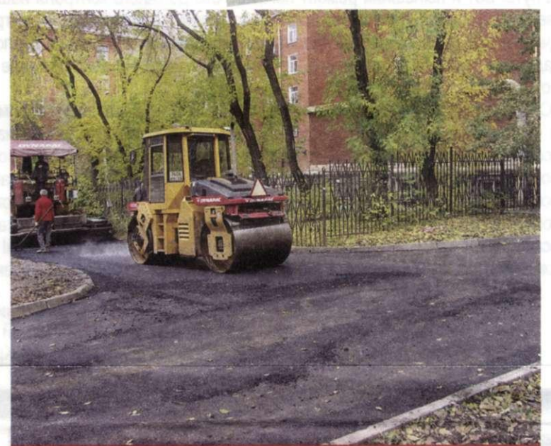
Ремонт проезда на ул. Коминтерна
